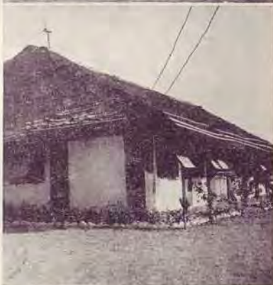
Construction par les élèves de l'école de la Mission
